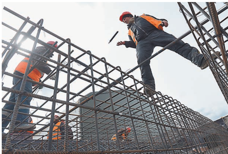
Быстро работая, строители минимизируют и неудобства для горожан.
